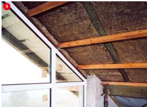
Provádění zateplení mezi krokvemi
