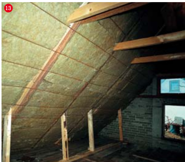
Ještě zbývá doplnit izolaci pod krokve
